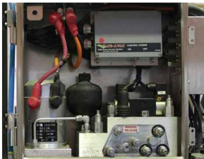
A Caixa de Força Safe-Away série 2009 é acionada pelo Controle do Sistema de Acesso. A Caixa de Força é adequadamente instalada verticalmente na lateral da escada.
