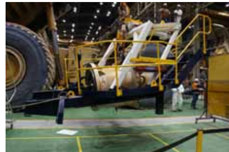
Подъемник для трансмиссии Trilift® Cat 797 и трансмиссия, опущенная на грунт.
