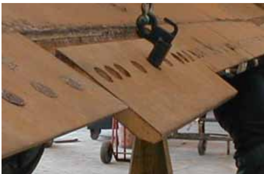
使用Trilift® 滑动式提升装置拆卸刀刃板
